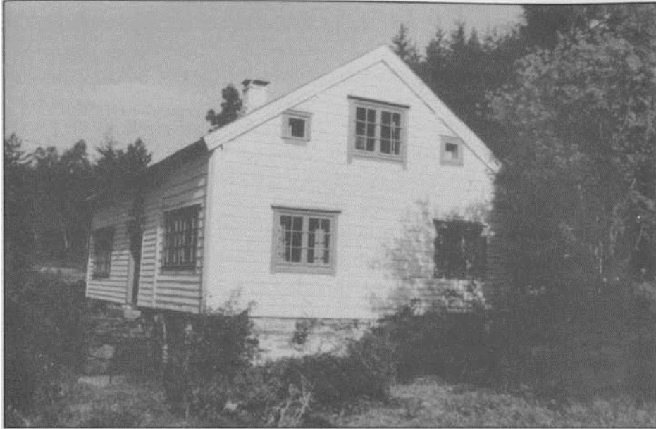
Huset til Signe og Petter Brune der tyskarane hadde stor-rassia for å leite etter våpen og anna ulovleg utstyr.
